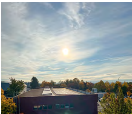
Erweiterte Photovoltaik auf der firmeneigenen Halle
