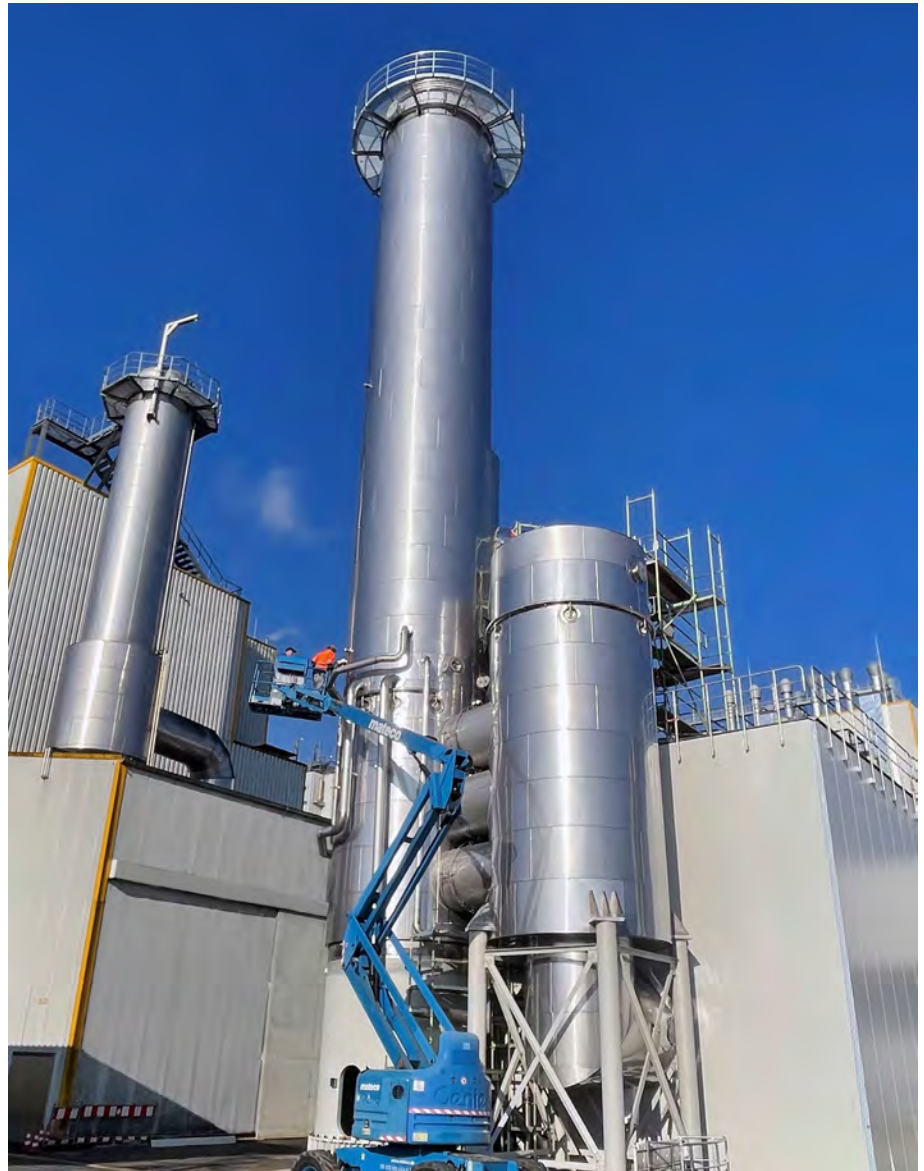
Letztes Handanlegen am Verdampfer bei unserem Kunden Jäckering in Hamm. Links das bereits 2016 realisierte Vor-Projekt.
